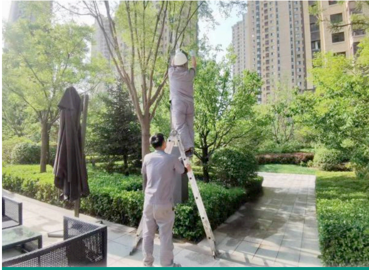
園區高杆燈 200W 更換 50W
